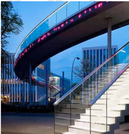
Telekom Brücke, Bonn / Deutschland
